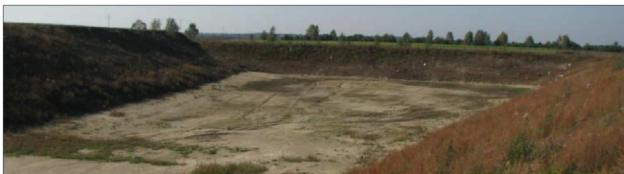
Kwatera odpadów azbestowych (w budowie)
