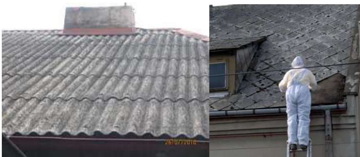
Ryc. 15. Rodzaje wyrobów zawierających azbest. Po lewej - płyty dachowe faliste (W02), po prawej - płyty azbestowo - cementowe typu „karo” (W01)
