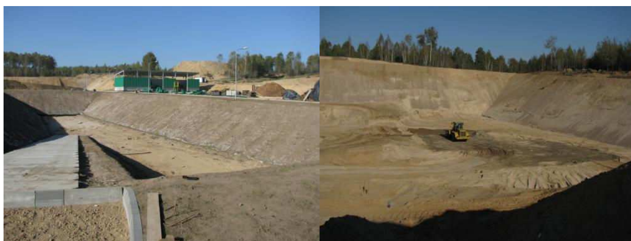
Ryc. 20. Zakład Przetwarzania i Unieszkodliwiania Odpadów w Czerwonym Borze - kwatery odpadów azbestowych (w budowie)
